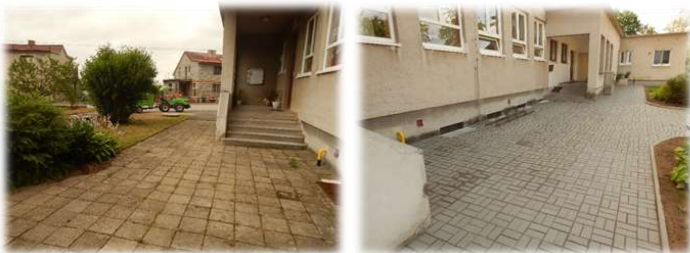
Plocha před budovou ZŠ a MŠ před a po rekonstrukci
