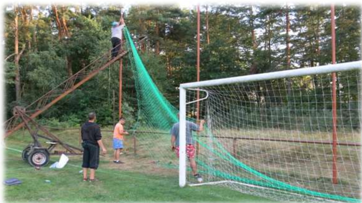
Ukotvení nové sítě za bránou.
